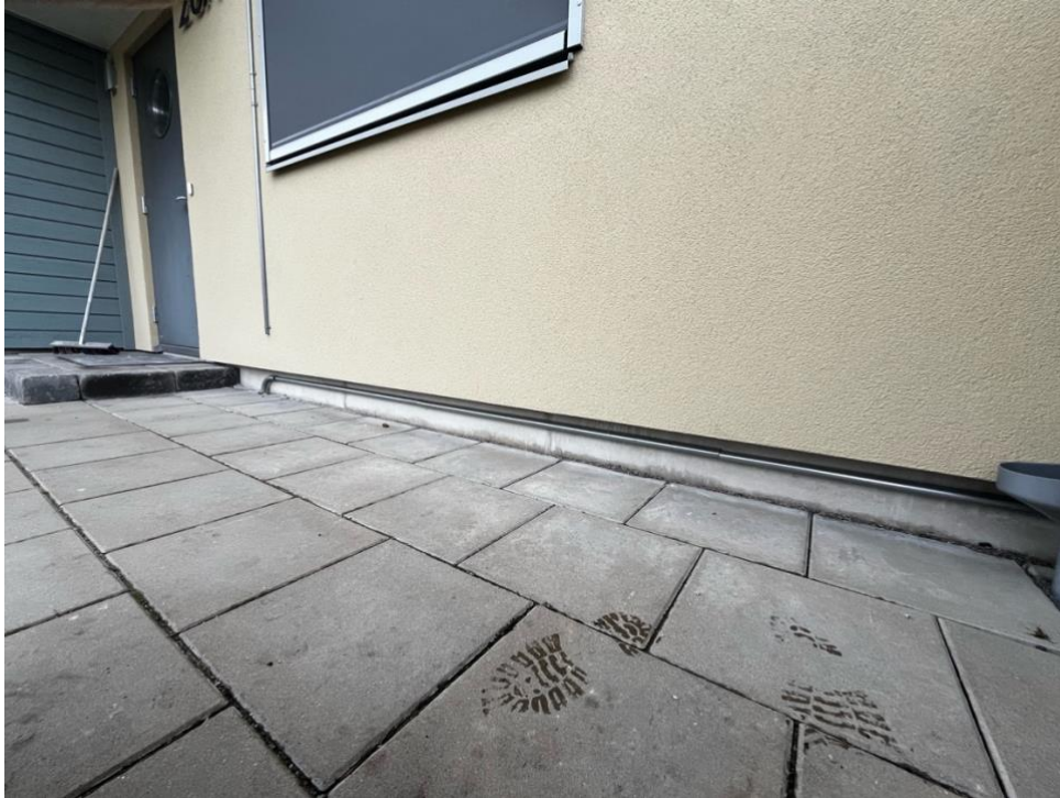
Figur 1 Foto av framsidan av enplanshuset med installation av elkablar längs grunden
