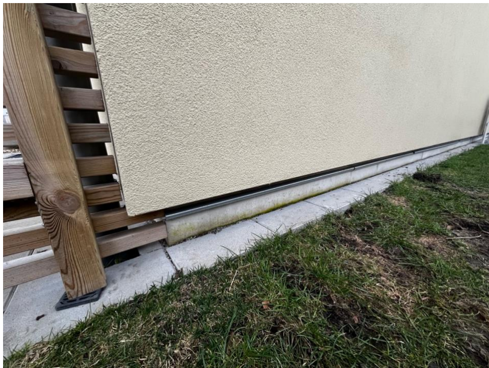
Figur 2 Foto av sidan av enplanshuset med installation av elkablar längs fundamentet
